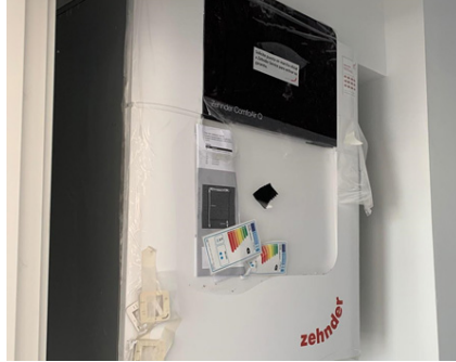
Figura 11. Sistema de ventilación con recuperador de calor. Vivienda en Carrión de los Condes (Fuente: Medgón Passiv Haus)
